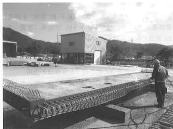
写真 - 5 高圧洗浄機による人力作業
