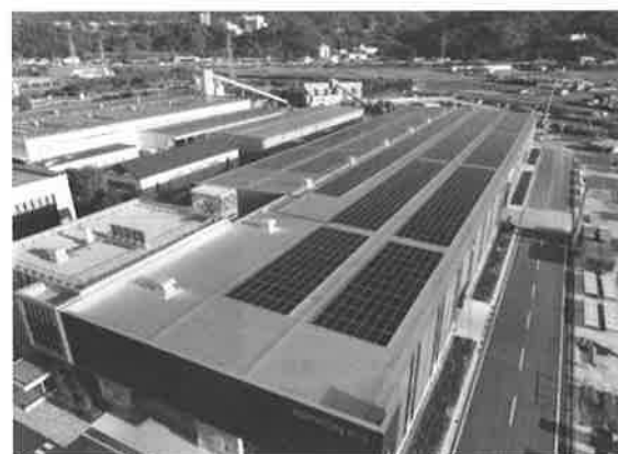
写真 - 7 太陽光発電パネル
